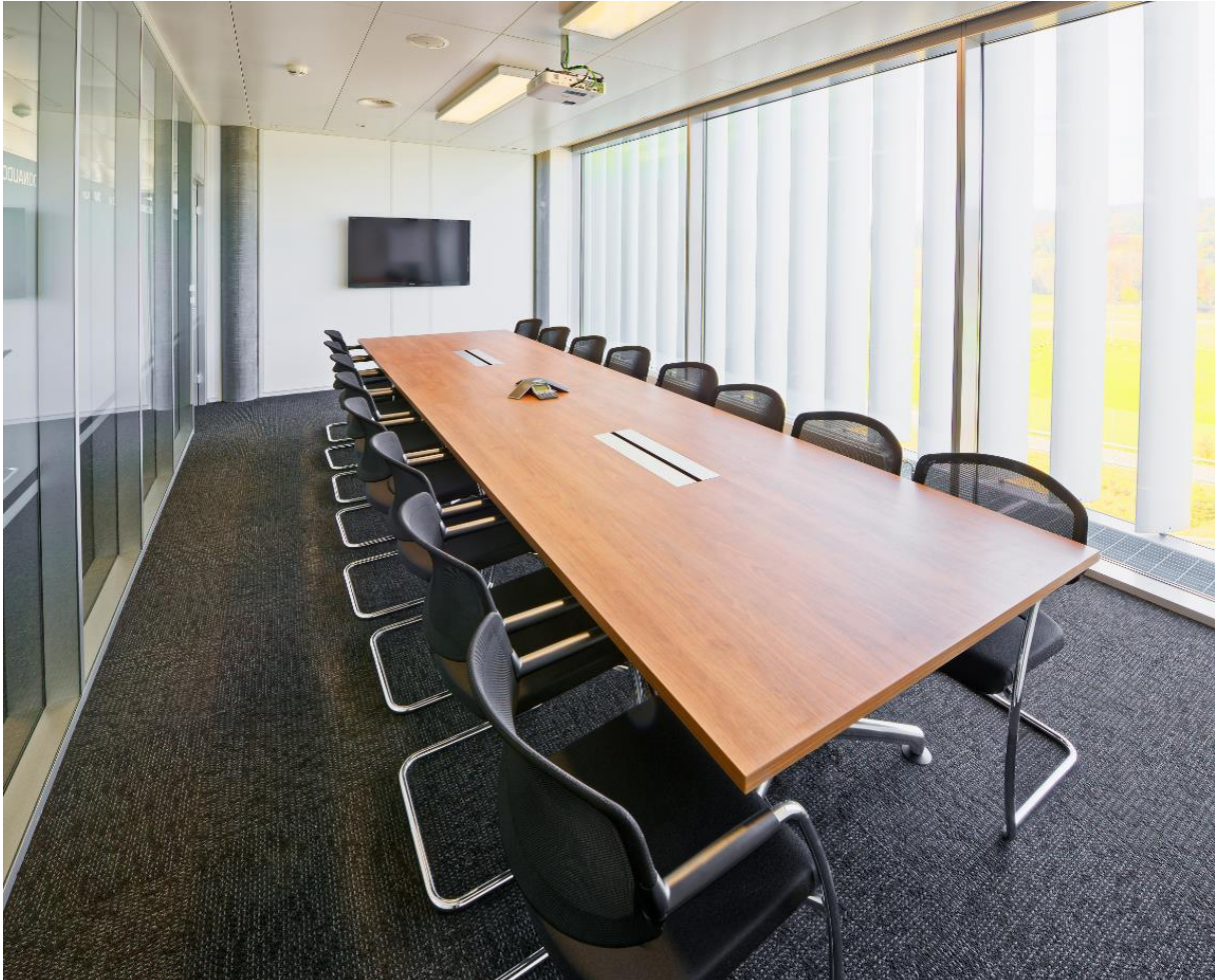
Figure 41: des lamelles pare-soleil installées à l'extérieur protègent de la lumière directe du soleil sans obscurcir complètement la pièce (facteur d'influence B13)
