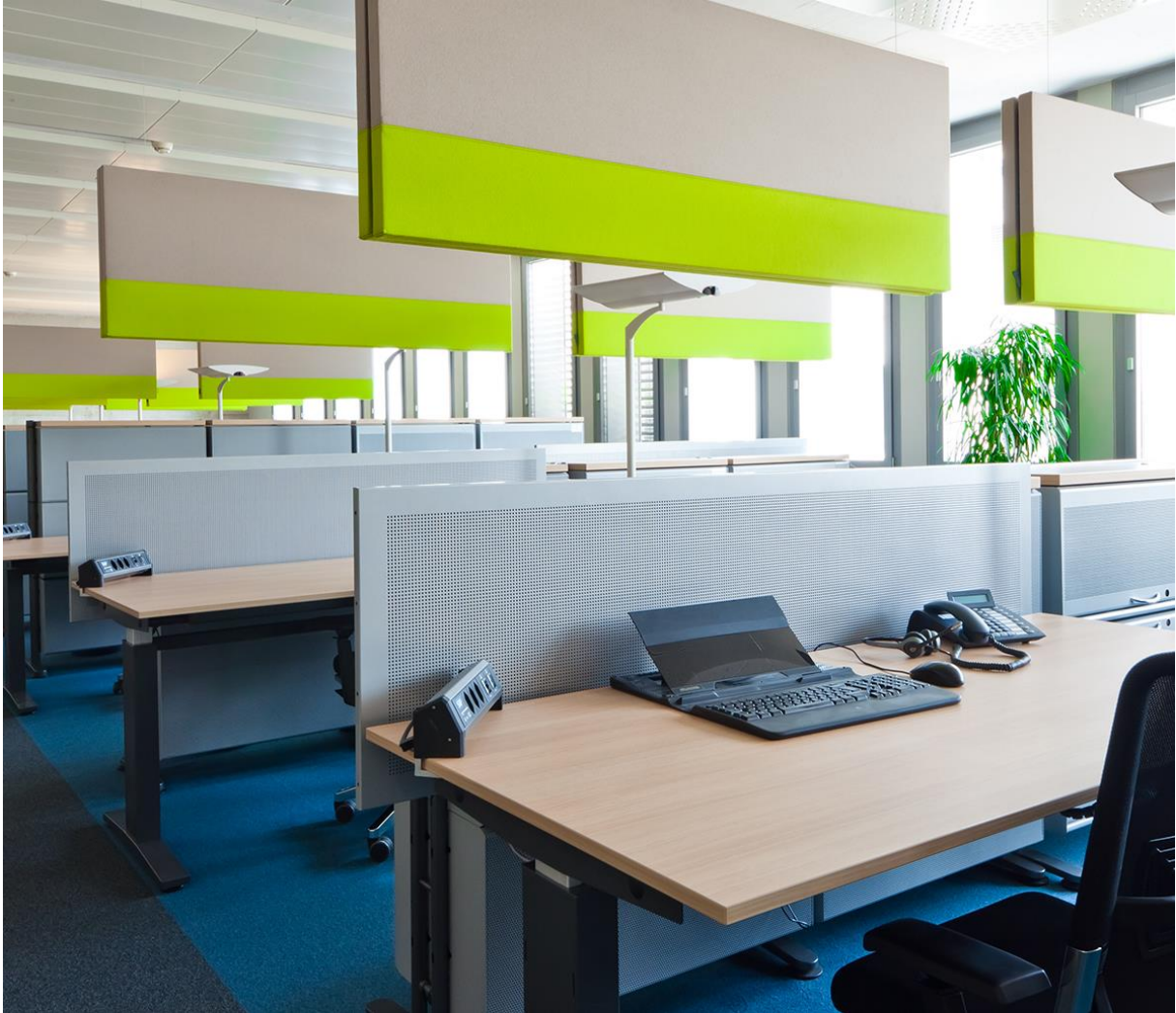
Figure 36: exemple négatif: des panneaux acoustiques suspendus offrent certes un bon isolement acoustique, mais sont perçus comme un élément oppressant dans l'espace (facteur d'influence B10)
